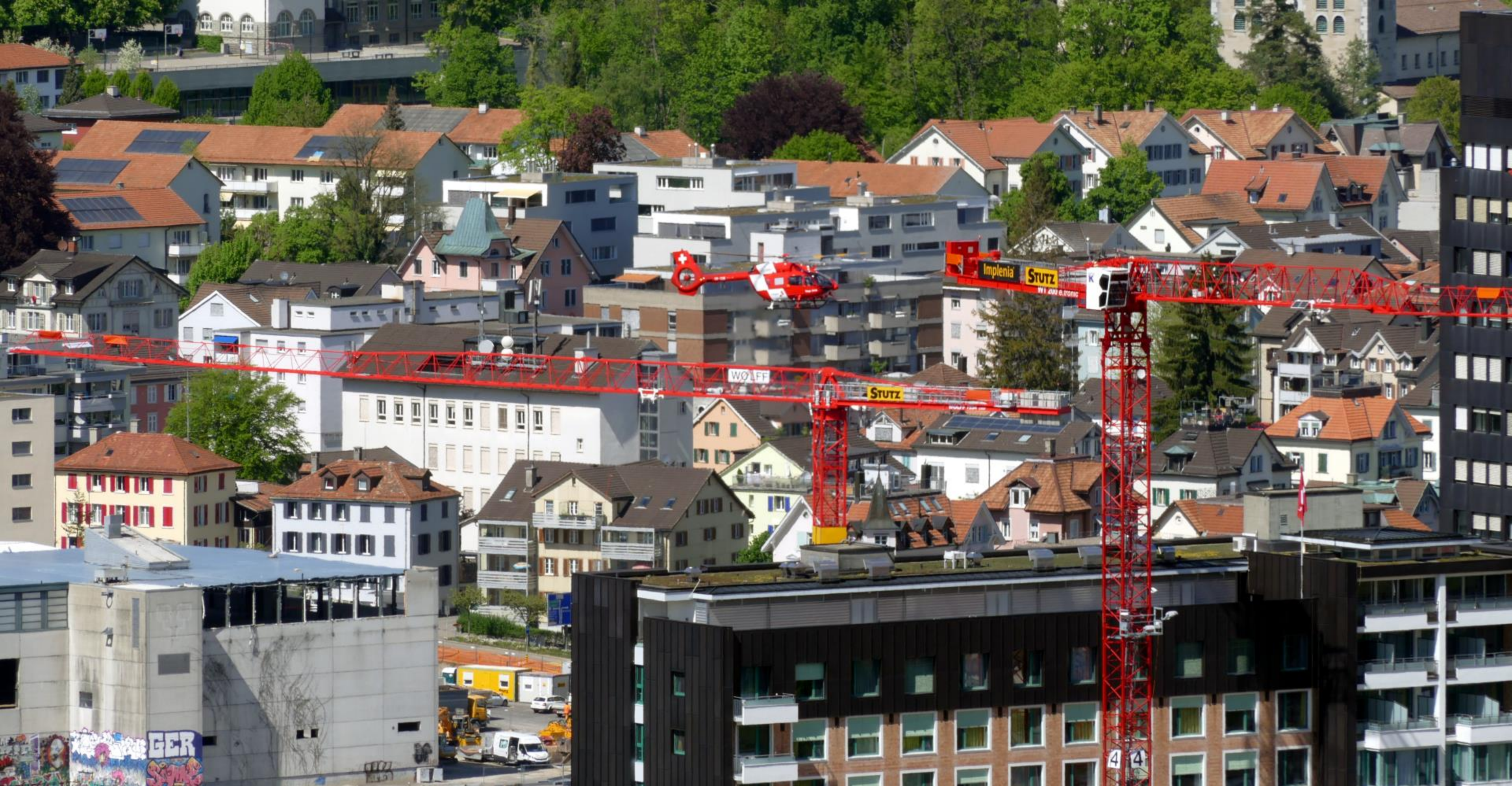
Der REGA-Heli fliegt und steigt rückwärts aus dem Landeplatz im Kantonsspital mit Baustellen
