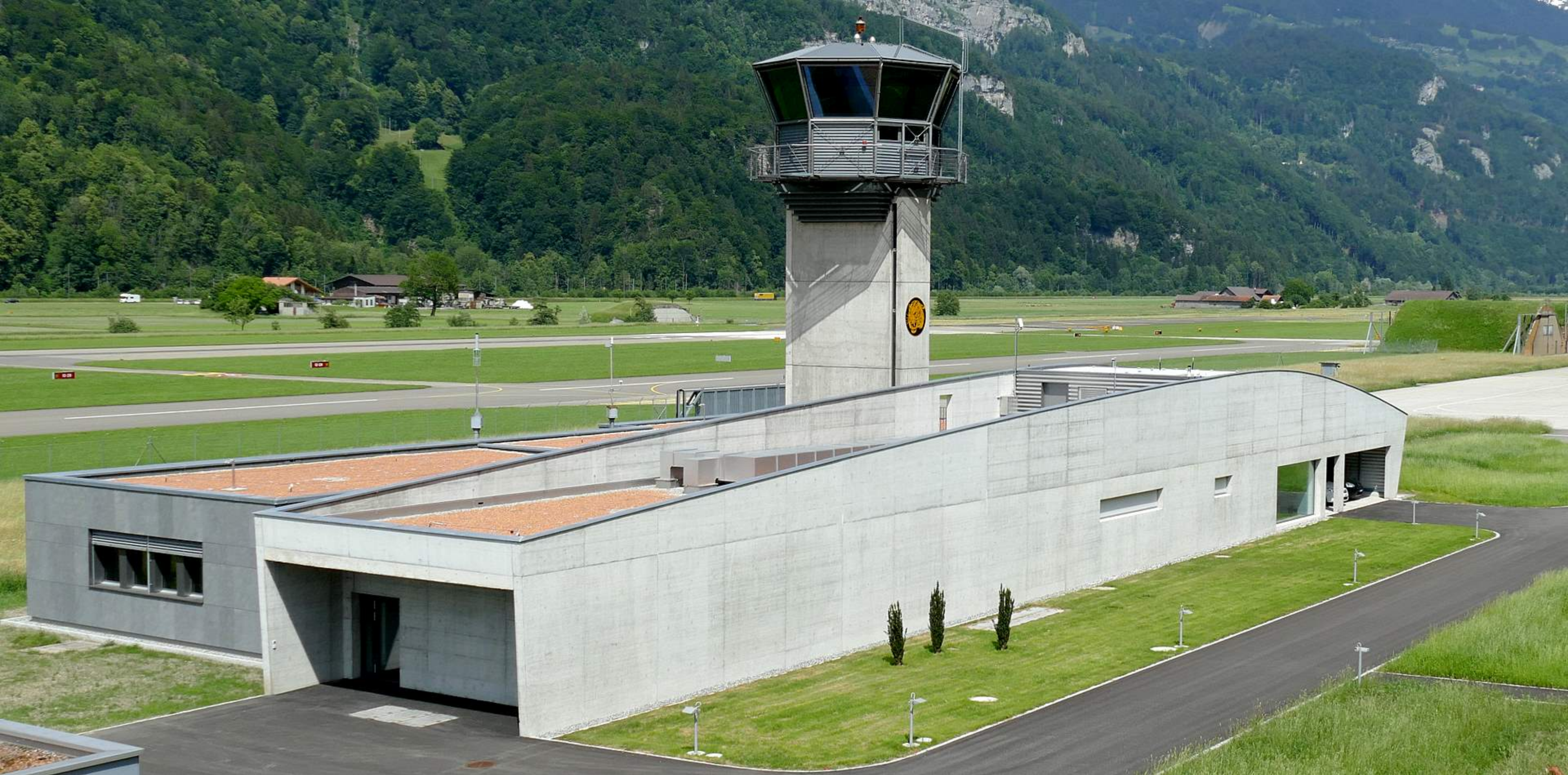
Unterbach, Tower LSMM mit dem Skyguide-Neubau · 4.6.2018 · Bild Carlos Bigler
